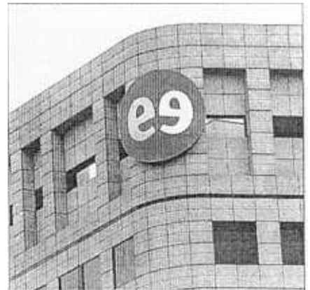
La sede barcelonesa de Retevisión no se ha visto correspondida con un contenido operativo real.
