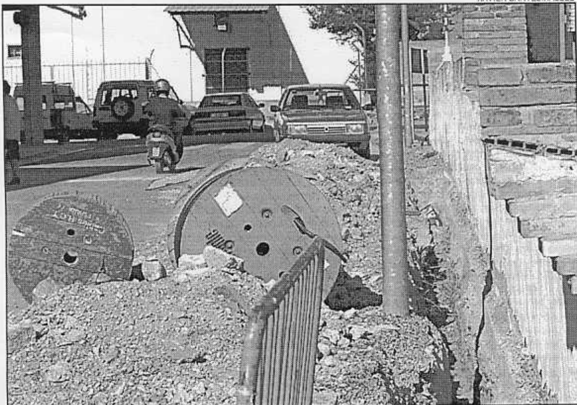
La instalación del tubo que llevará el cable se ha iniciado en diferentes ciudades. En la foto, Cervera.
