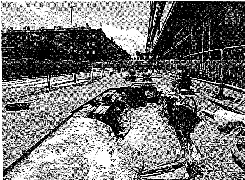
Obres de cablejat al carrer Pau Casals de Girona. Algunes operadores ja han iniciat els treballs en diferents zones de Catalunya. / JORDI SOLER.
