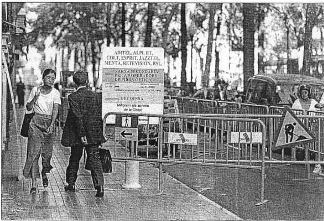
Obres d'instal·lació de cable a la Diagonal de Barcelona l'estiu passat
